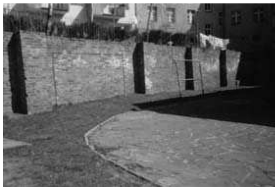
Odcinek "parkanu" najbliższy byłej bramie. Mur kurtynowy - rozebrany. Na zwingerze wybudowano domy. Z mapy z 1928 r. wynika, że mur kurtynowy wówczas jeszcze istniał i łączył się z domem pokazanym na rysunku z lewej.
